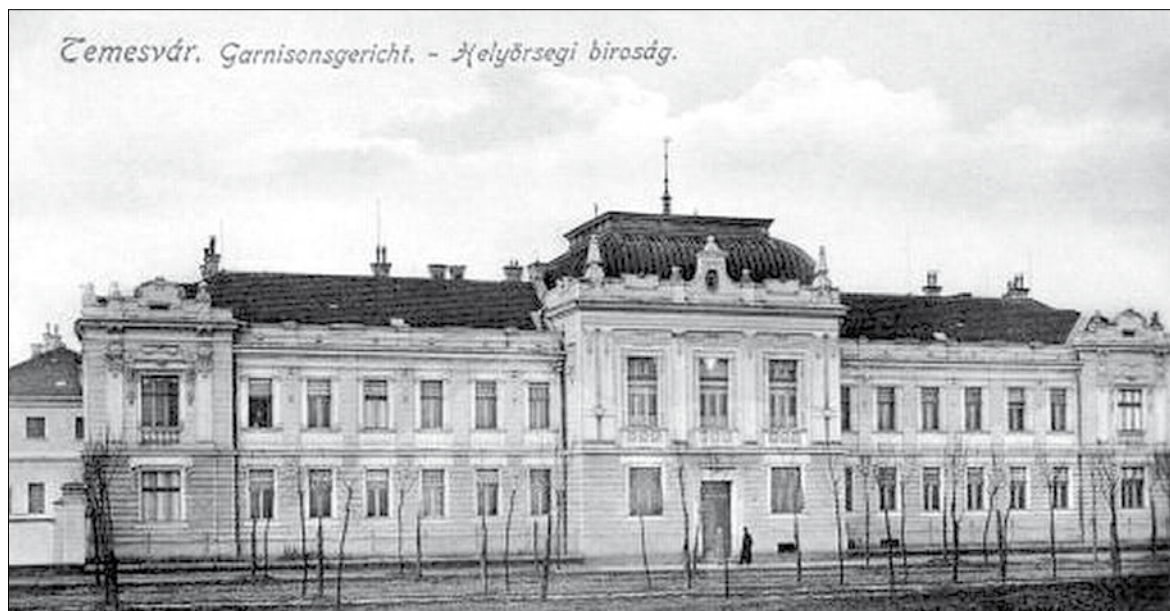
Temesvár, a helyőrségi katonai bíróság épülete (1912)
